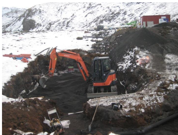
Unnið við söndun efra sandsíulags. (29.01.2013)
