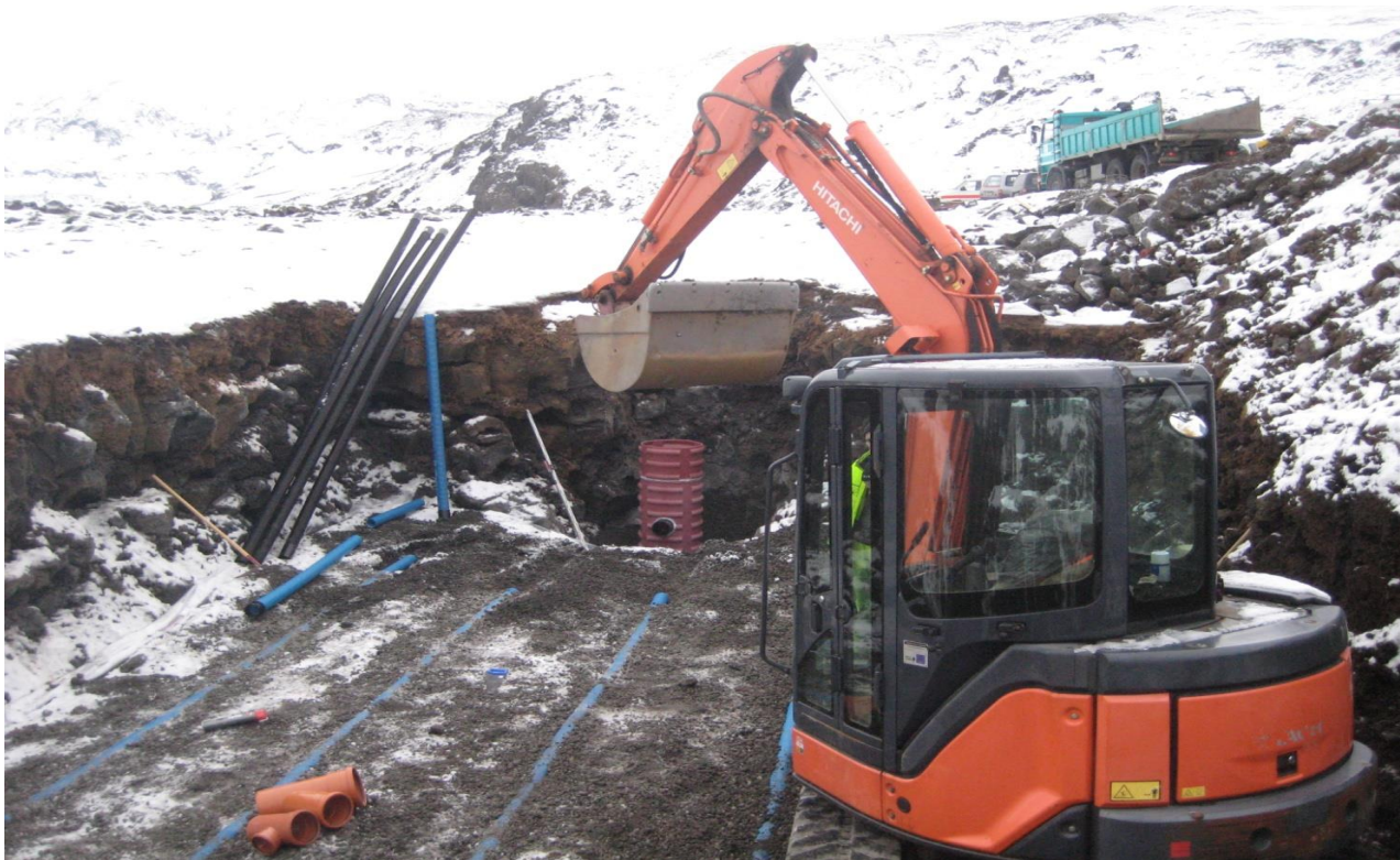
Unnið við niðursetningu neðri hluta siturlagna sandsíunnar, sýnatökubrunnur fyrir miðju. (28.01.2013)
